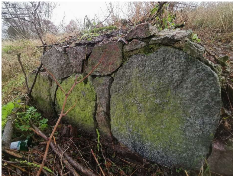
Abbildung 7: Feldsteinmauer mit Spalten, nördlich der Vorhabenfläche
